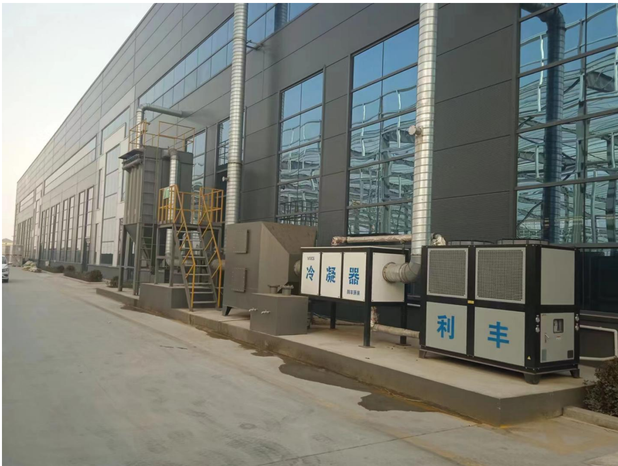
除尘器、二级冷凝设施、15 米高排气筒 DA001
