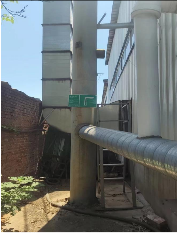
油烟净化器+活性炭吸附装置+15 米高排气筒 DA001
