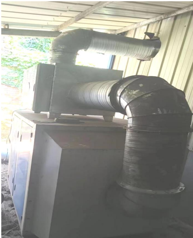
油烟净化器+活性炭吸附装置+15 米高排气筒 DA001
