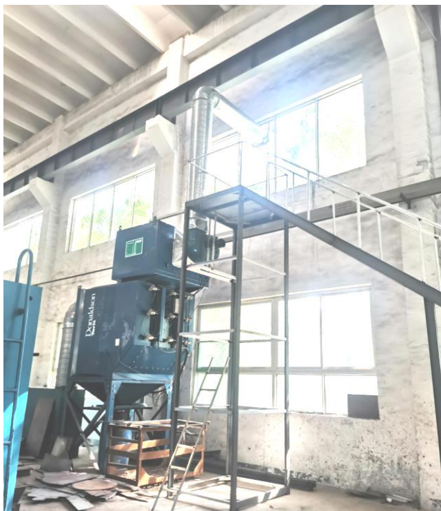
等离子、火焰切割工序：除尘设备+排气筒 P1
